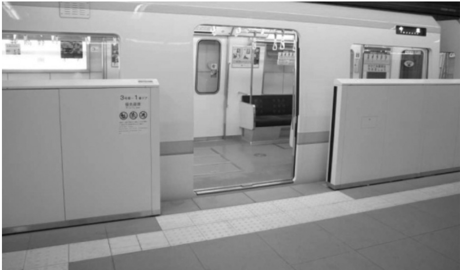
Fotoğraf 6. Metro vb. kentsel raylı sistem istasyonlarında duyumsanabilir yüzeylerle engellilerin yönlendirilmesi
