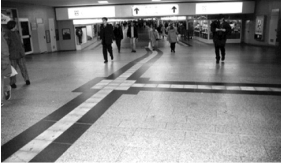
Fotoğraf 5. İstasyon ve terminalerde kılavuz iz ve yönlendirme ögesi örneği (Naniopoulos, 1999)
