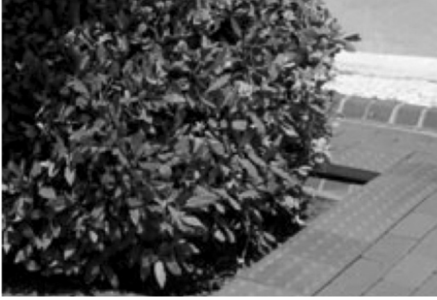
Fotoğraf 17. Nesnelere karşı yaya yolu kaplamaları ile uyarma (www.raf.arkitera.com.tr)
