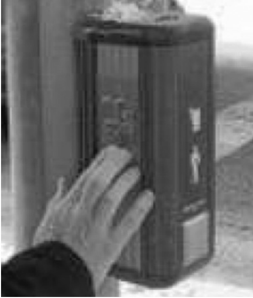
Fotograf 8. Braille alfabeli, dokunarak işletilen sesli uyarıcı (DfT, TScot, 2008)
